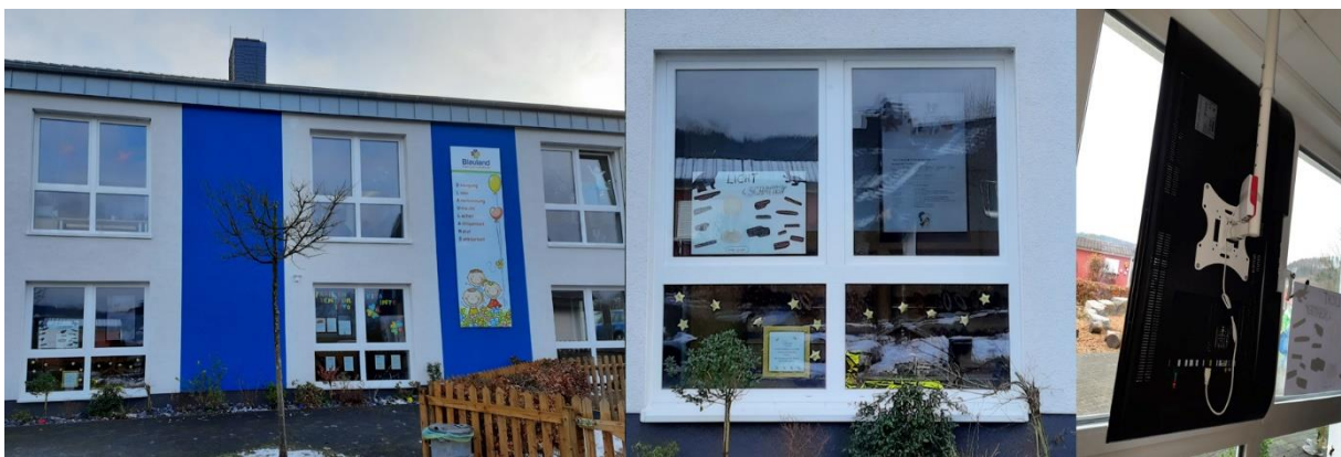
Abbildung 55: Das Familienzentrum Blauland mit Kita und dem montierten Screen hinter der Scheibe
